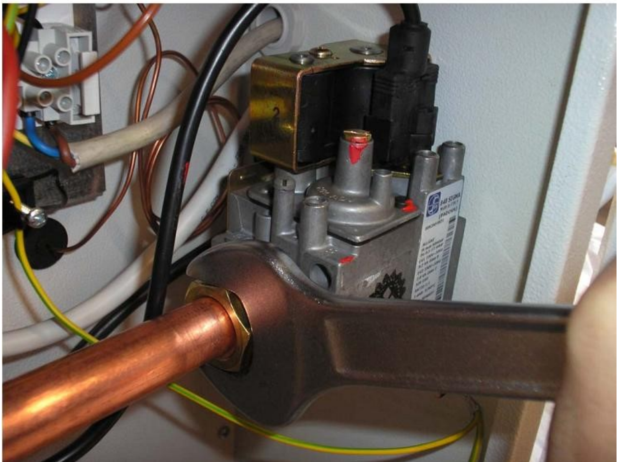
Rysunek 5.1 Demontaż przewodu gazowego
